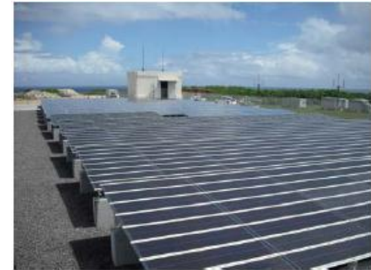
設施外觀照片
